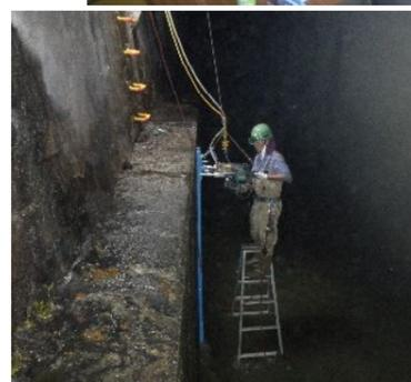
レール工法はカルバートや反力がとれない場所での施工に最適です。
