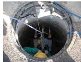
直壁削孔
