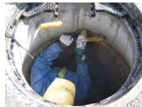
ステップ切断工
