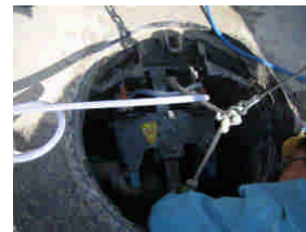
斜壁削孔
