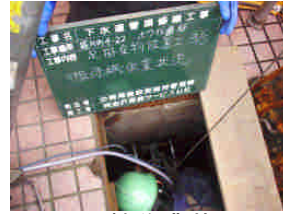
取付機作業状況
